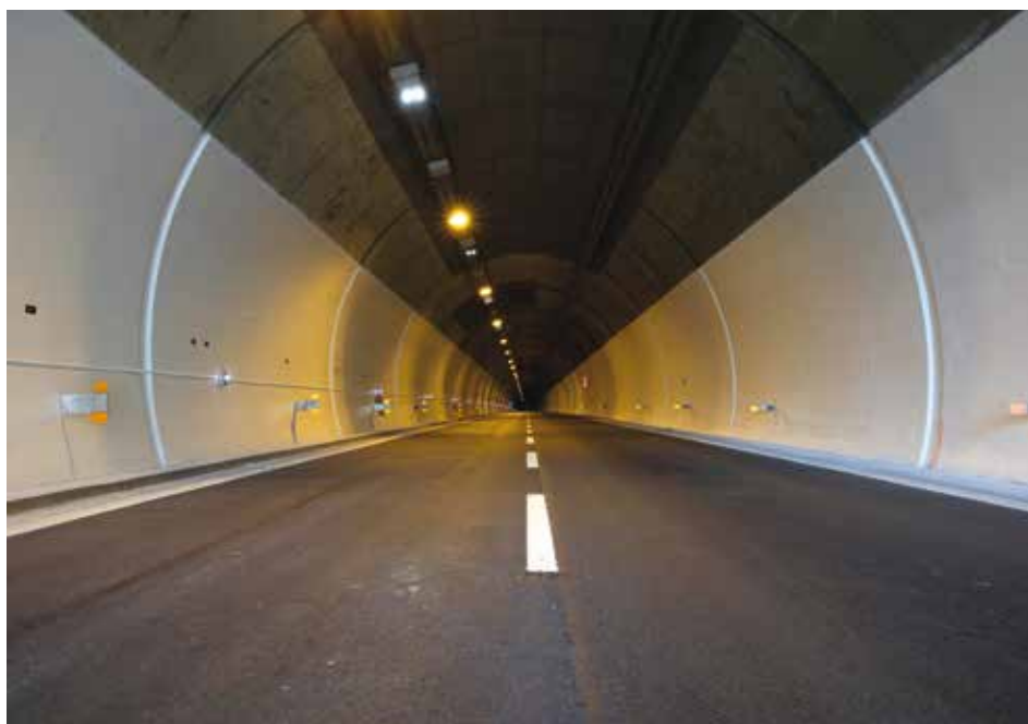
4. La galleria Moggio Sud al termine delle lavorazioni
