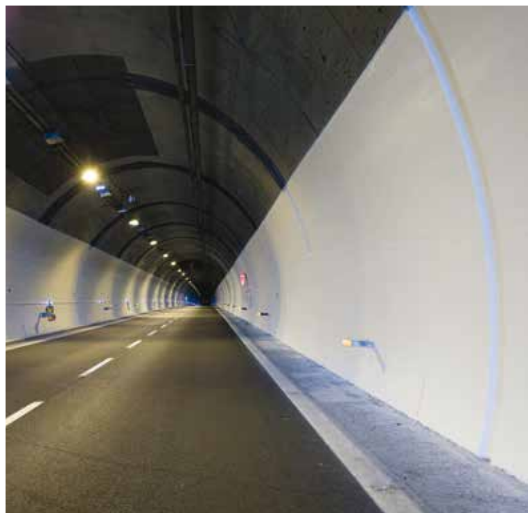
5. Un dettaglio del piedritto destro
