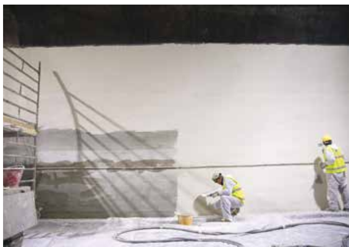
3. La fase di rasatura delle superfici
