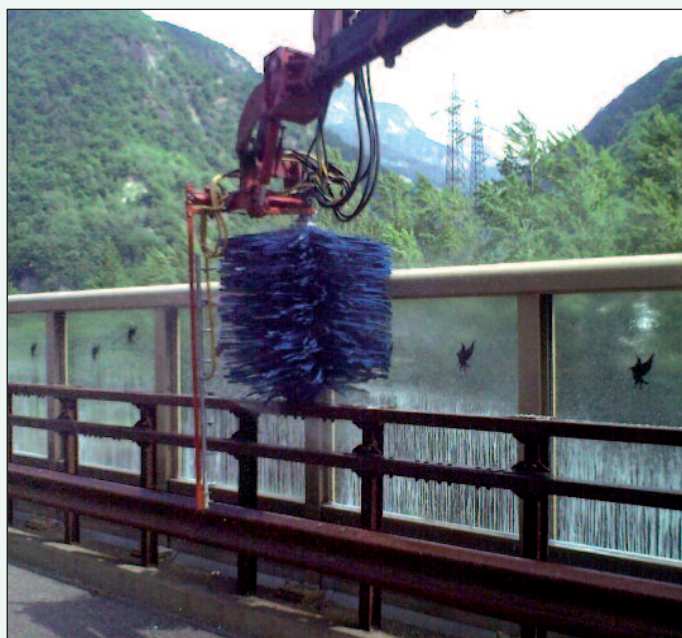
Figura 3 - Un esempio di spazzolone rotante dell'altezza di 100 cm
