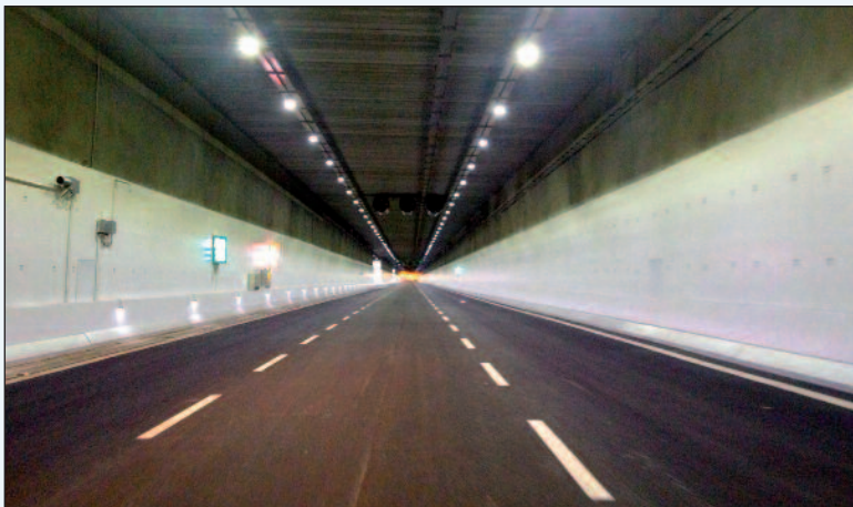
4. Il tunnel di Monza sulla S.S. 36
