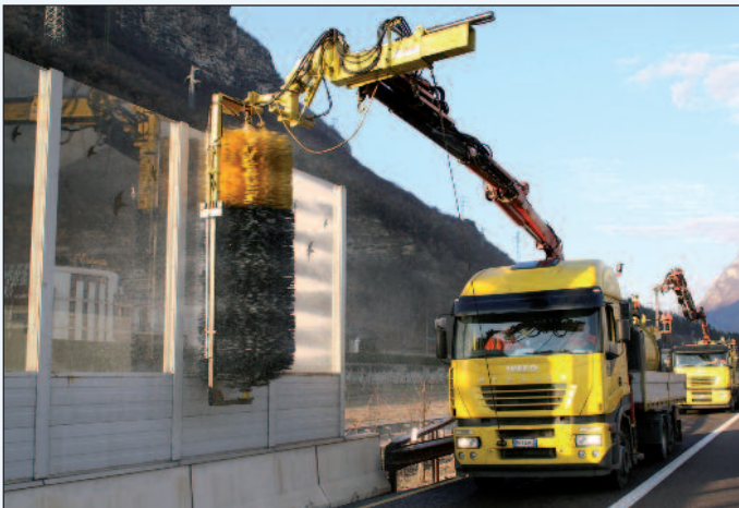
6. La fase del rotolavaggio di pannelli antirumore
