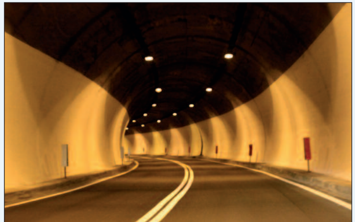
5. Il tunnel verniciato in seguito all'intervento di idroscarifica
