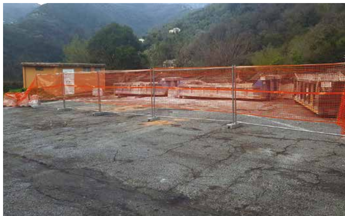
1. L'allestimento delle aree di stoccaggio per i materiali di risulta
